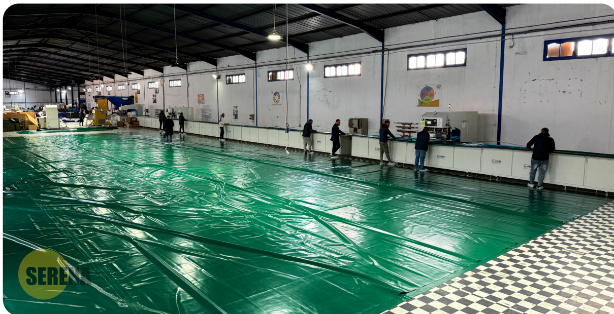
Κατασκευή δεξαμενής 1000 κυβικών μέτρων
